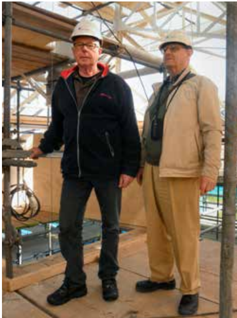
Huub van der Aa en Ruud de Meij tijdens een inspectie bij de renovatie van de Wintertuin.
