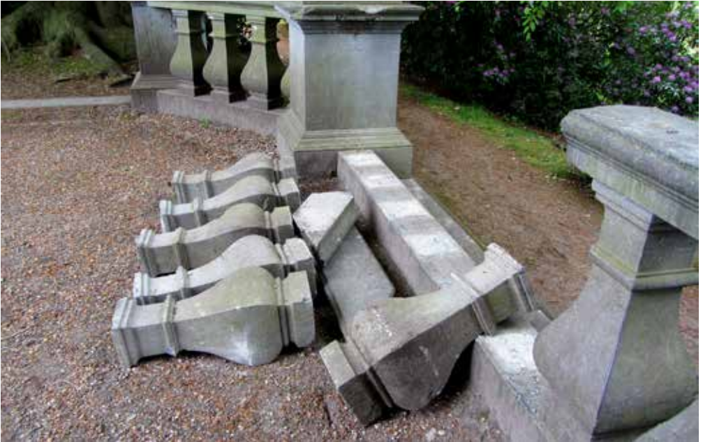
De brokstukken van de balustrade van de colonnade, nadat ze bij elkaar geraapt zijn.
