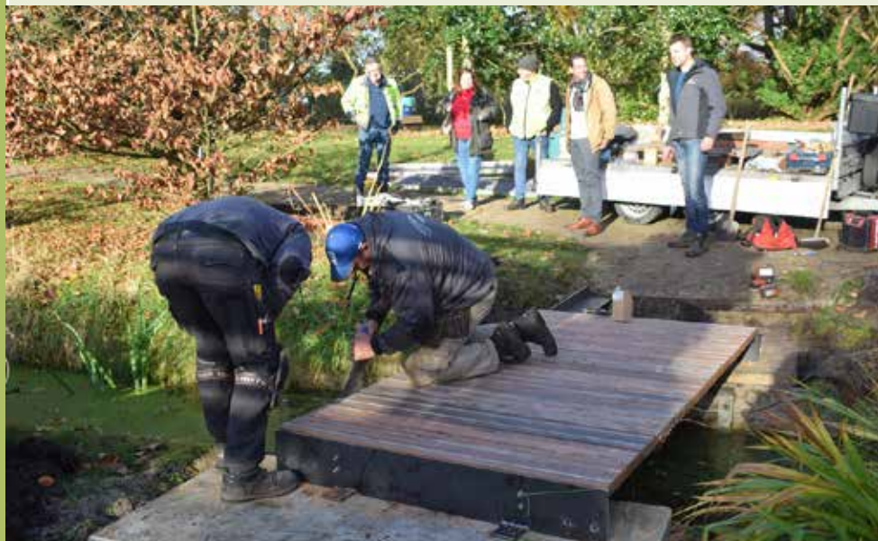
Tijdens het plaatsen van de nieuwe brug bij de pergola werken de mensen van HSB Bruggen (Baarn) alles nog nauwkeurig bij (foto Christine Schut).
